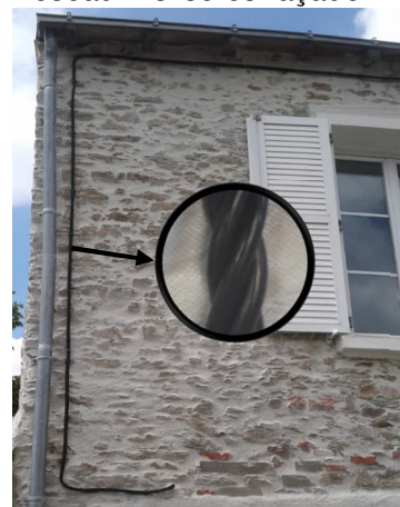
Réseau fils isolés façade BT
